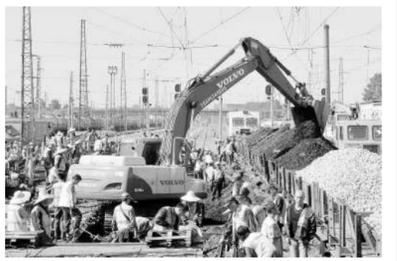
四平工务段在铁路道岔大修中，及时将废旧轨料清出场地，做到完工完料净场地清。图为近日该段在四平站道岔大修施工中，将清出的残土装车运走。 孙忠仁摄
