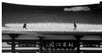
7月26日,工作人员正在为长沙杜甫江阁顶部装纱网。自入夏以来,高温一直“雄踞”长沙,连续高温日数不断刷新当地最长纪录。经连续26天在35℃以上高温暴晒后,位于长沙湘江边的杜甫江阁琉璃瓦自24日起开始脱落,碎瓦时不时往下掉。发现碎瓦后,工作人员马上用纱网在屋檐周围兜了一圈,避免伤人。
