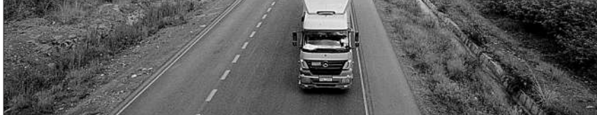
这是5月16日拍摄的中国路桥工程有限责任公司已修建完工的肯尼亚首都内罗毕市东北环城路。已于2012年3月完成的东北环城路不仅为肯尼亚内罗毕市区道路和A2国道交通提供了优质的绕城交通疏解方案,有效疏通了内罗毕严重的交通拥堵状况,更为沿线居民区和商业区提供了前所未有的高等级道路服务。
