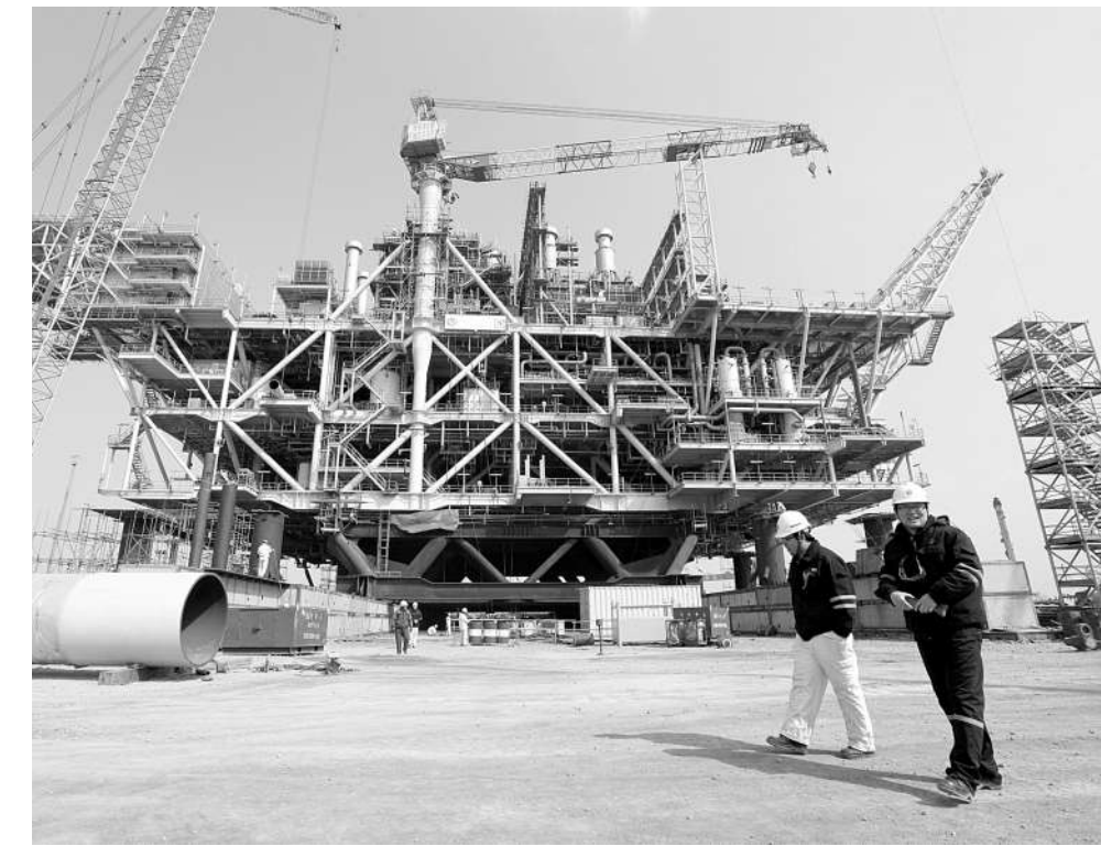
4月10日,山东省青岛市,我国自主研发、亚洲最大的深海油气平台荔湾3-1天然气综合处理平台在位于开发区的海洋石油工程(青岛)有限公司建造场地顺利完工。该平台浮托重量达到3.2万吨,历时21个月建造。据悉,该平台拖拉上船后还要安装、调试,预计5月初起航驶青岛运往南海。CFP供图
