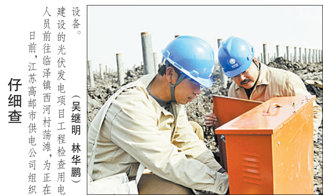
建设的光伏发电项目工程检查用电
